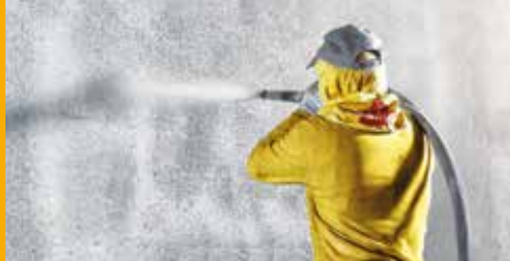
BETONSCHUTZ UND INSTANDHALTUNG
