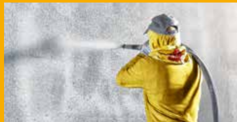
BETONSCHUTZ UND INSTANDHALTUNG
